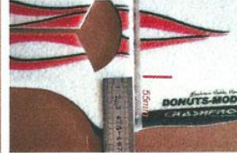
8 Réalisez la saignée qui permettra l'insertion du gouvernail de direction.
